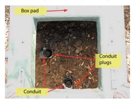
Figure 58—Conduit Placement - Single-Phase Transformer
