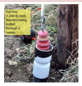
Figure 28—Conduit Proofing
