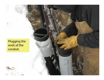
Figure 29—Plugging the Conduit
