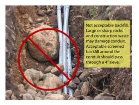
Figure 16—Unacceptable Backfill
